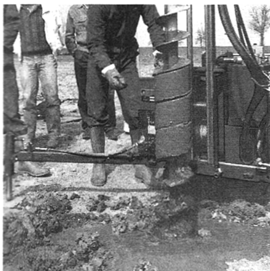
Obr. 4.45 Strojní vrtání šnekem (prospekt fy Eijkelkamp)
