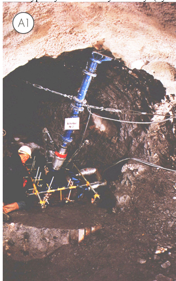
Obr. 11.22 Orientovaná smyková zkouška s předurčenou plochou porušení (fy INTERFELS Salzburg)
