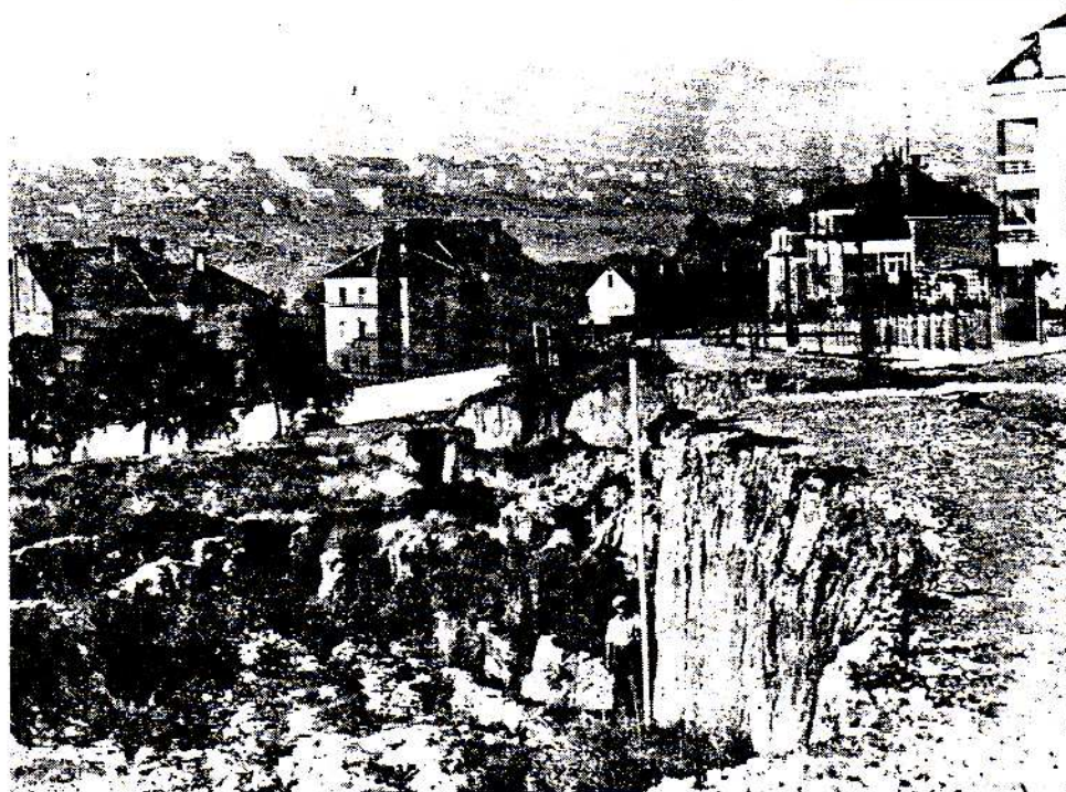
14-10. Sesouvání strmého svahu staré cihelny ve Střešovicích ohrozilo okolní zástavbu i komunikace. (Foto Q. Záruba.)
